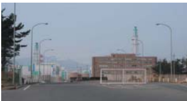
六ヶ所再処理工場（建設中）
