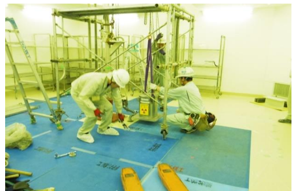
線源交換作業（照射室内設置）同上
