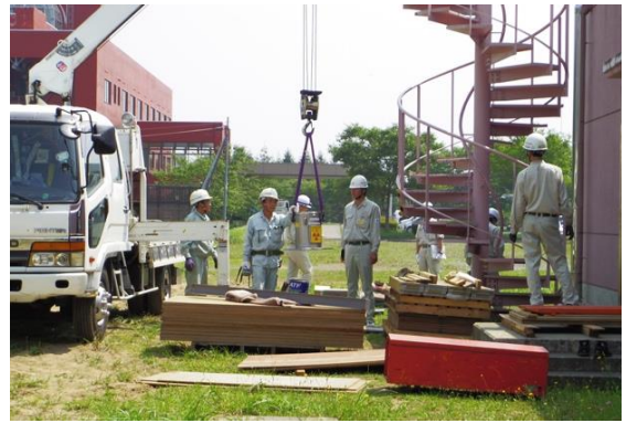
線源交換作業（搬入）平成26年7月29日
