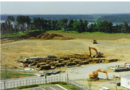
閉鎖型生態系実験施設建設工事開始時（平成 6 年）
