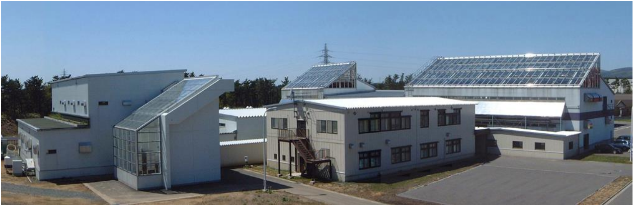
閉鎖型生態系実験施設（平成 13 年竣工）外観
