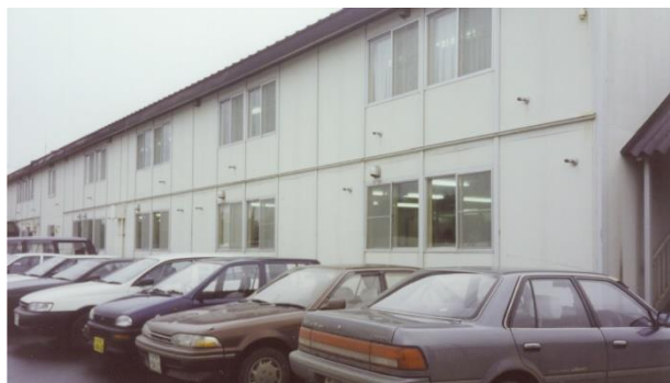
写真1 環境科学技術研究所が発足してから本所移転までの間、事業を実施した仮設事務所。撮影：平成5年4月8日
