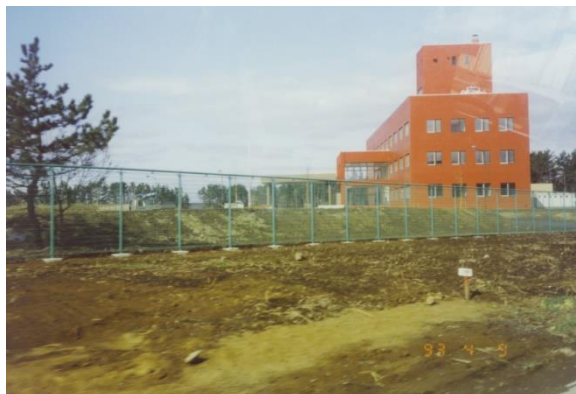
写真3 平成5年4月9日、竣工直後の本館周辺の様子
