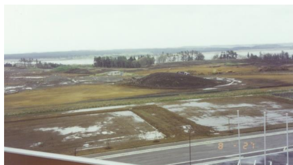
写真4 平成5年5月10日、本館竣工直後の本所整備工事の様子
