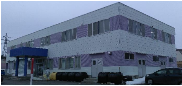
図 13 生物圏物質循環総合実験棟（居住実験研究棟）。1階に植物栽培実験用人工気象器（図 16）を設置した部屋、炭素・水素同位体を測定する同位体質量分析装置（図 17）・イオンクロマトグラフ等を設置した分析室及び試料前処理室、水生生物を用いた実験を実施できる防水床・排水溝を持つ実験室（図 18）等、2階に研究員室、会議室等を備える。
