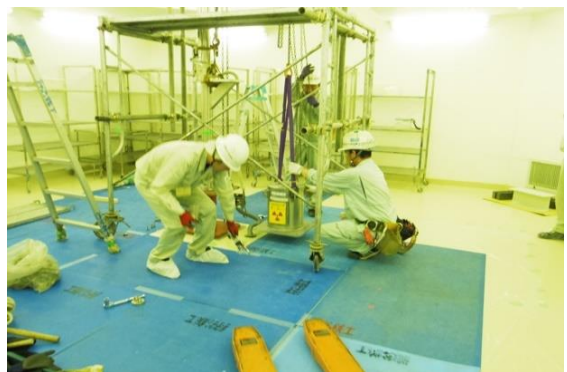
線源交換作業（照射室内設置）同上
