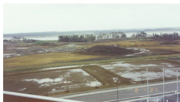
写真4 平成5年5月10日、本館竣工直後の本所整備工事の様子
