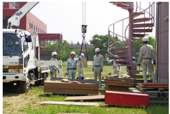
線源交換作業（搬入）平成26年7月29日
