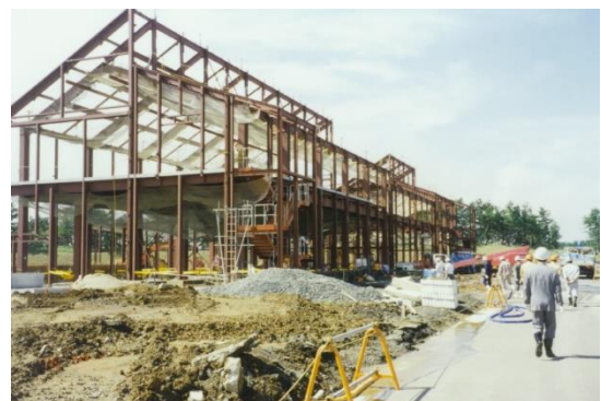
閉鎖型生態系実験施設建設工事の様子（同左）
