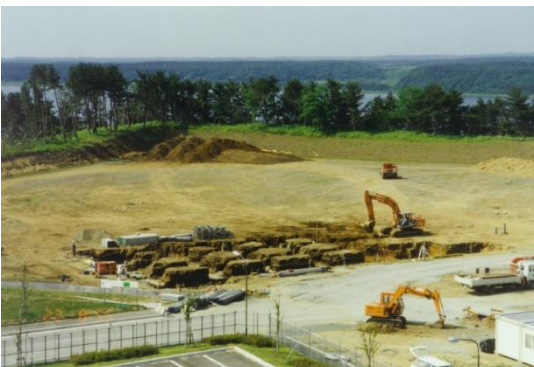
閉鎖型生態系実験施設建設工事開始時（平成 6 年）
