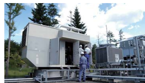
自家発電機の試運転
