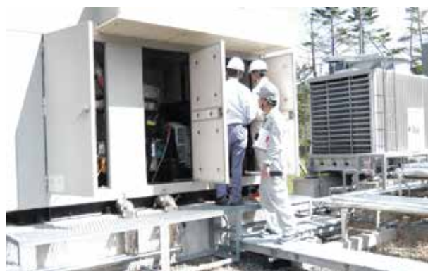
職業体験の様子（自家発電機）
