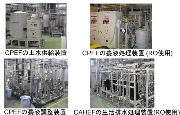
図8 閉鎖居住実験で用いた水処理システム
