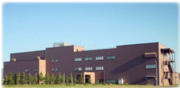
図1 全天候型人工気象実験施設の外観
