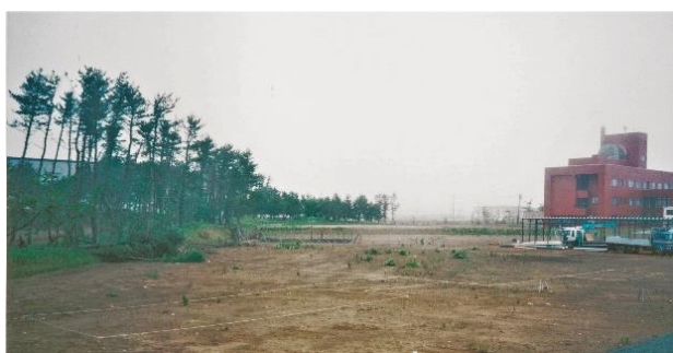
図 1 低線量棟建設工事開始 (平成 6 年 7 月 7 日)
