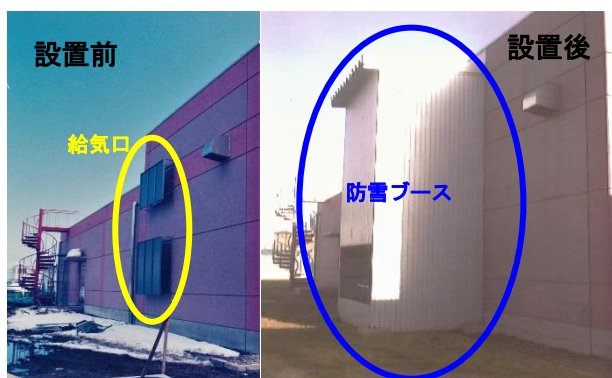
図 2 防雪ブースの設置 (平成 7 年)
